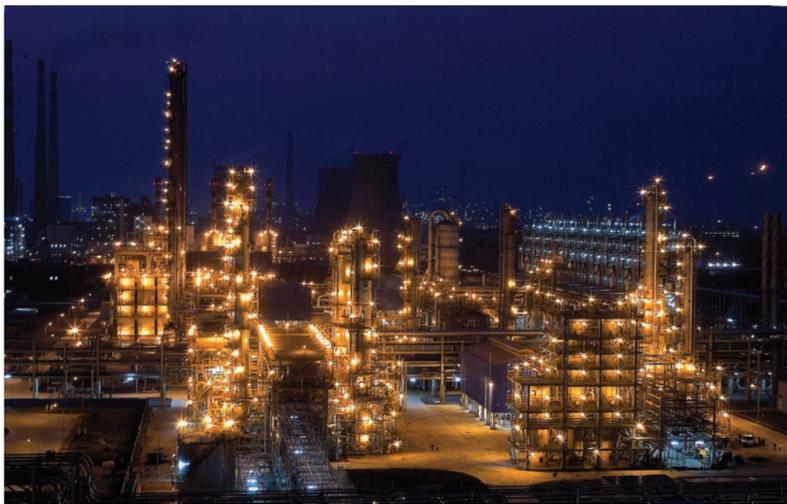
Abb. 2: Das Foto zeigt den Steamcracker am Verbundstandort Nanjing in der Nacht. Er wird von BASF-YPC, einem Jointventure zwischen BASF und Sinopec betrieben. Das Jointventure betreibt auf dem 220 Hektar großen Werksgelände am Jiangtse-Fluss den Steamcracker mit einer Jahreskapazität von 600.000 Tonnen Ethylen sowie neun Downstream-Anlagen.
