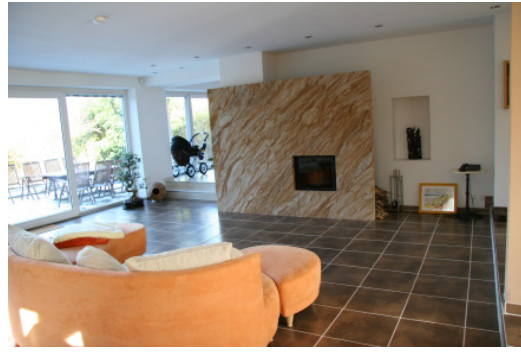
Kamin = wassergeführt mit 24 KW Wasserleistung und 6 KW Luftleistung
