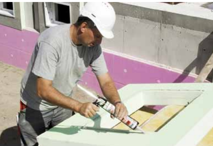
Montage einer MEAFIX-Dämmplatte
