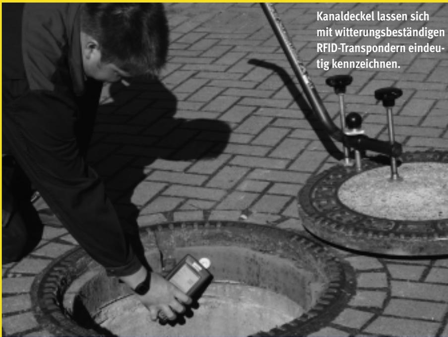
Kanaldeckel lassen sich mit witterungsbeständigen RFID-Transpondern eindeutig kennzeichnen.
